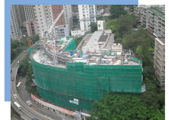
正在建造之主樓正視圖
