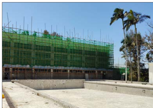
外圍棚架的搭建和瓷磚拆除工程已接近完成
