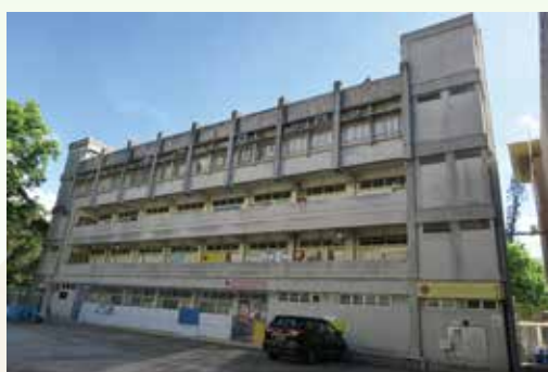
「躍薈」位於沙田文禮路 23-25 號 2 樓全層
